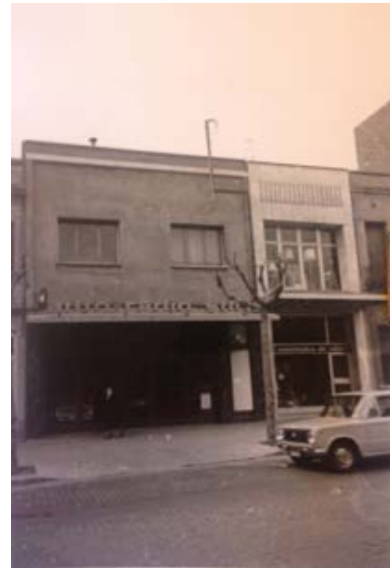
Fotografia exterior de l'establiment Auto-radio Surià, extreta de la fitxa del parcel·lari de l'Ajuntament de Sabadell. Autor desconegut.
